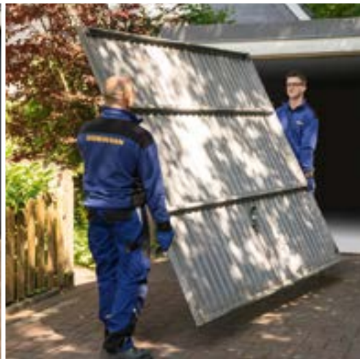
Ausbau und umweltgerechte Entsorgung
